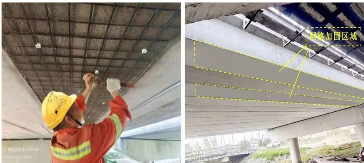
宿淮塩高速道路の梁体底板補強
