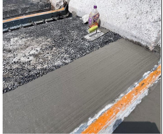
(3) 広州道路空港二高鶴嘴相互連絡立体交差橋(伸縮継手に構造型チョップドストランド)
