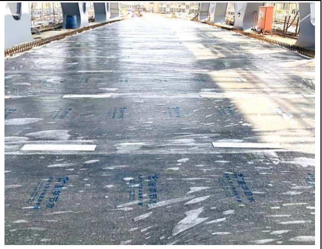
(5)福州港羅湾港区可門作業区(鋼橋舗装に構造型チョップドストランド)
