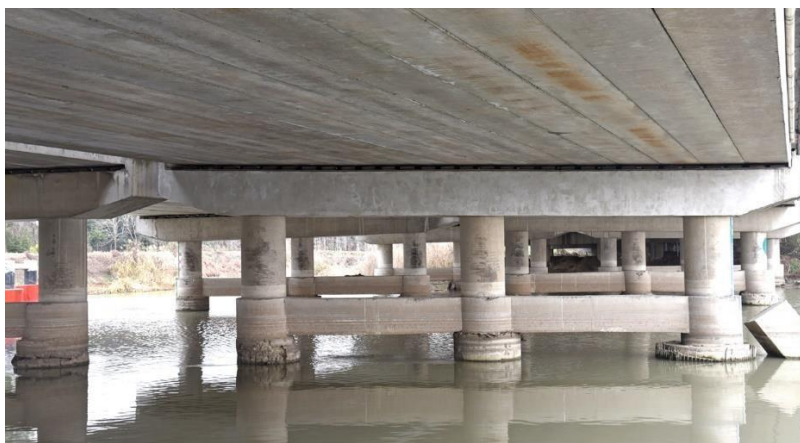
常州市南河橋の蓋梁補強
