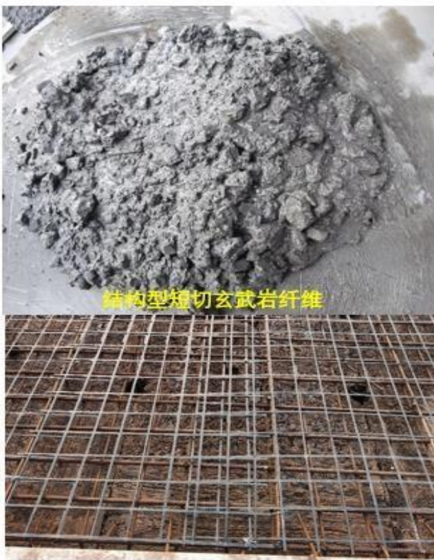
(5)福州港羅湾港区可門作業区(鋼橋舗装に構造型チョップドストランド)
