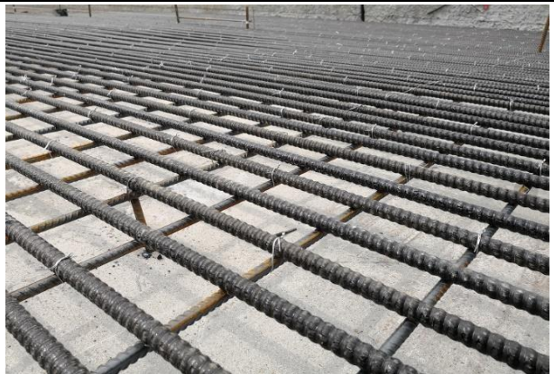
南京長江大橋の引橋脚の頂上の後打ち帯の補修
