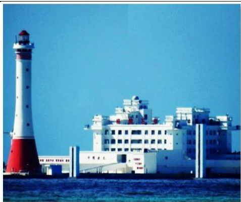
三沙市某島礁灯杭
