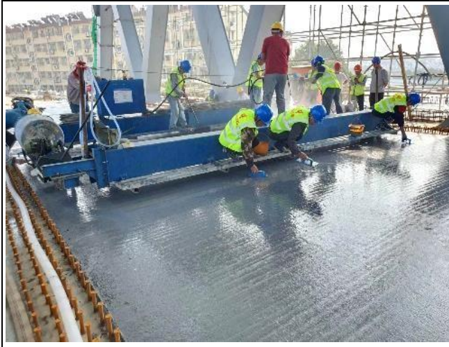
(5)福州港羅湾港区可門作業区(鋼橋舗装に構造型チョップドストランド)
