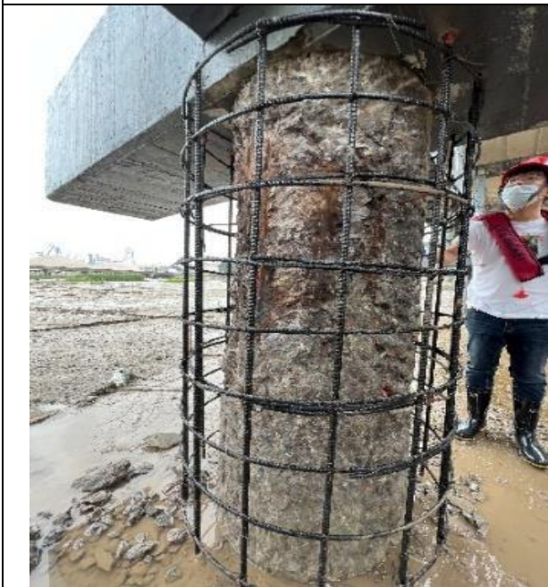
寧波甌山港老池山二期港口柱拡大断面補強
