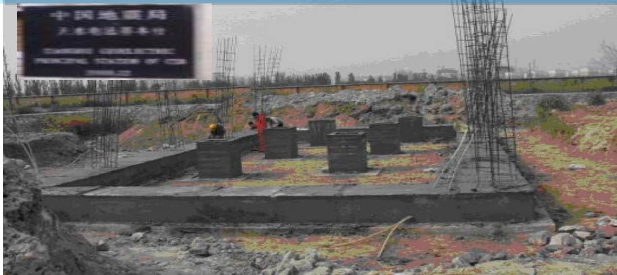
天水・銀川・蘭州・嘉峪関玄武岩纖維筋地震観測台
