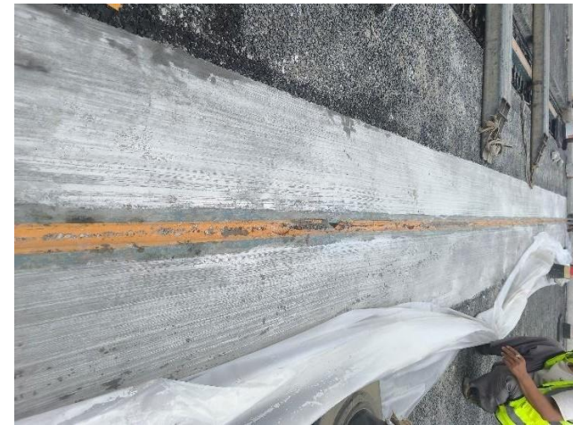
(4) 江蘇省泰州市北水関大橋(鋼橋舗装に構造型チョップドストランド)
