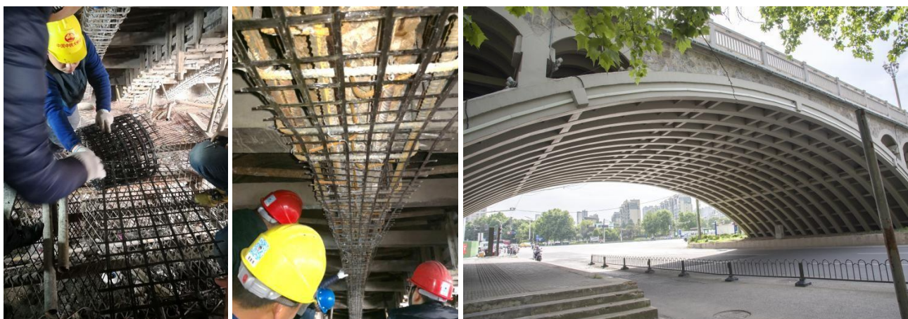
南京長江大橋双曲アーチ橋補強
