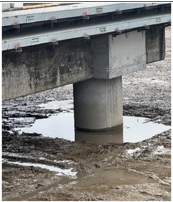
寧波甌山港老池山二期港口柱拡大断面補強
