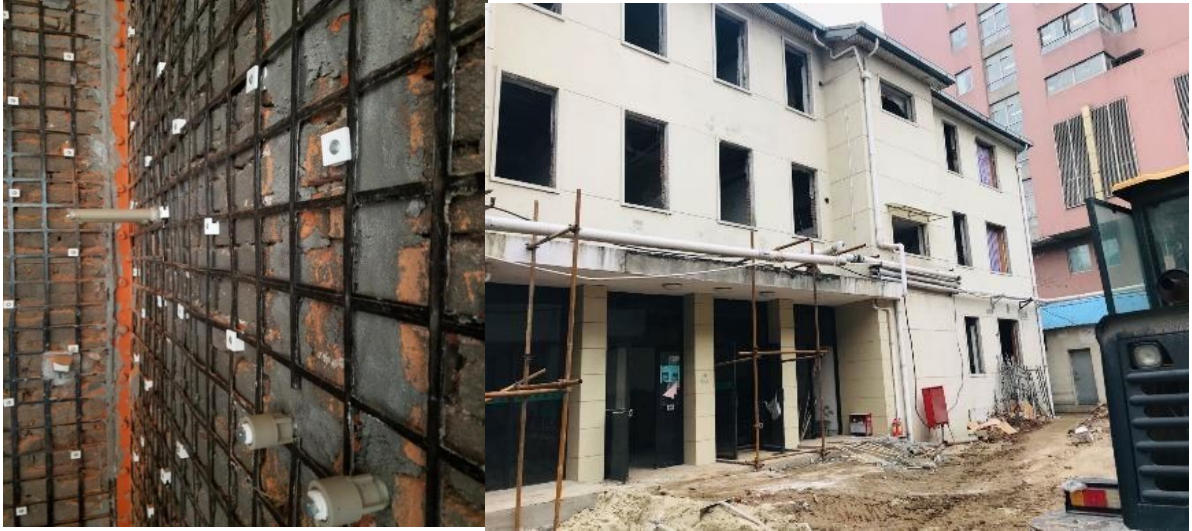
南京大学鼓楼キャンパスの外国人教師マンションの補修・補強
