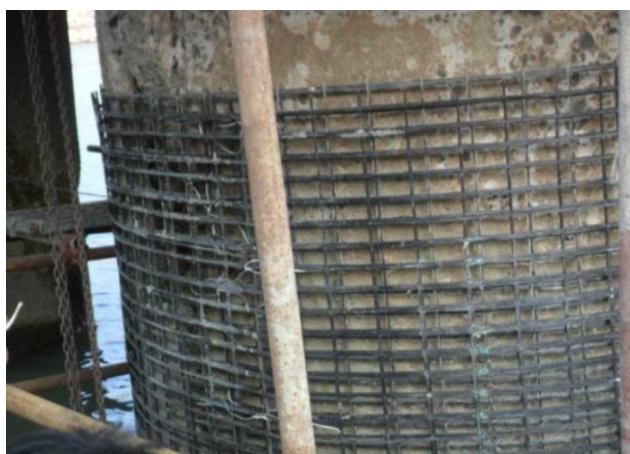
杭金地高速道路衢州孫姜大橋の橋脚補強
