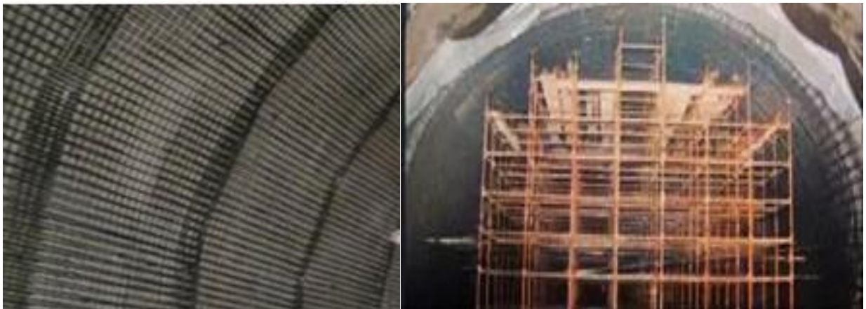
北京地下鉄復八線トンネル補強
