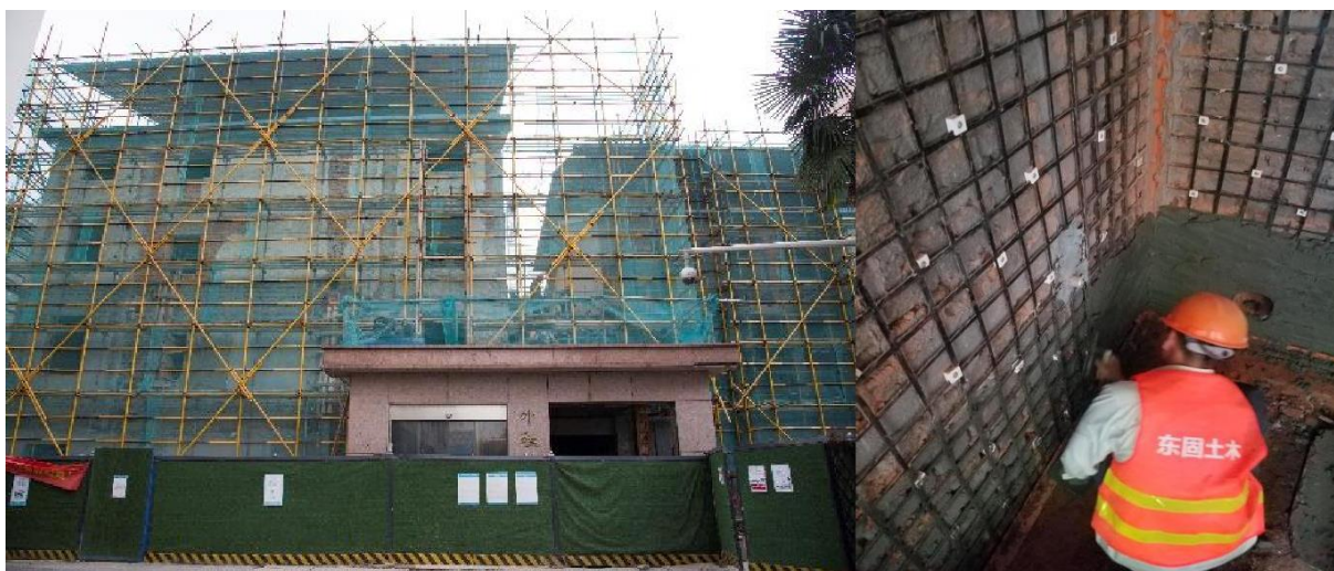
南京大学鼓楼キャンパスの外国人教師マンションの補修・補強
